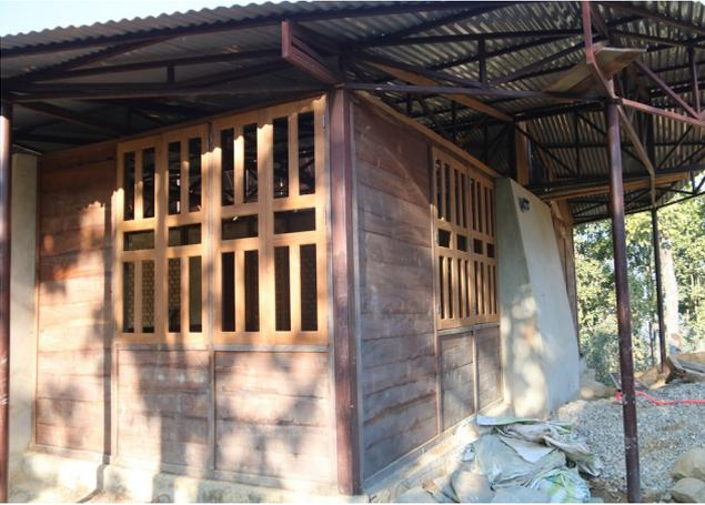
Détail du mur extérieur en bois et de la nouvelle menuiserie.
