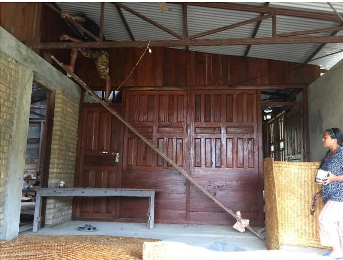
Vue des menuiseries de la salle de classe de la cuisine depuis la salle de classe extérieure (couverte). Travaux sur les menuiseries intérieures et la finition des plafonds (avec isolation) en cours.
