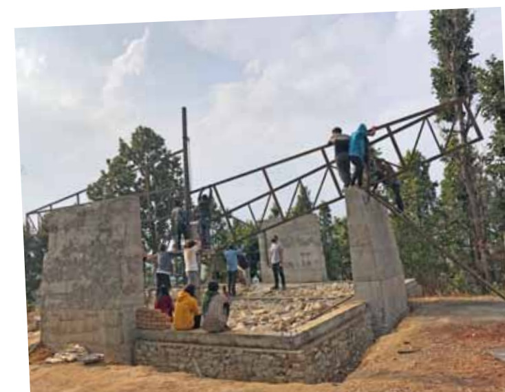
L'armature centrale est montée et mise en place à la force des bras!
