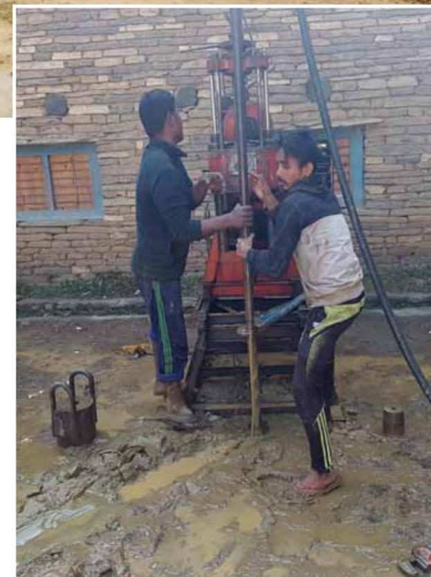
Entre-temps on a déjà sondé le sous-sol en y prélevant plusieurs échantillons. En effet, s'il y a trop de roches dures, cela pourrait poser des problèmes pour les fondations. Heureusement l'analyse des échantillons était positive et le feu est au vert pour débiter les travaux.
