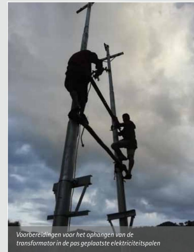
Vorbereidingen voor het ophangen van de transformator in de pas geplaatste elektriciteitspalen
