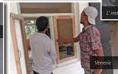
Les travaux de peinture sont en cours de finition
