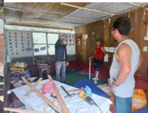
Plaatsing verlaagd plafond in het kleuterklasje van de basisschool in Haku Besi.
